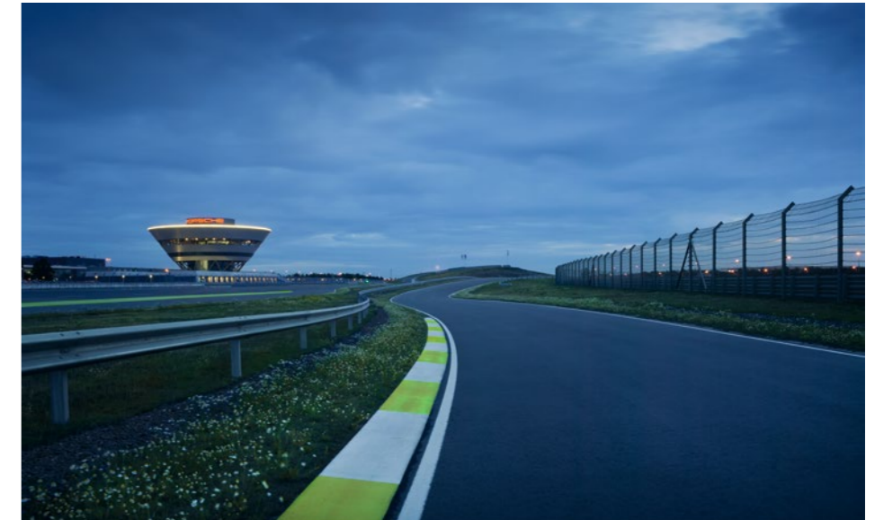
TEST- UND PRÜFSTRECKE STANDORT LEIPZIG
